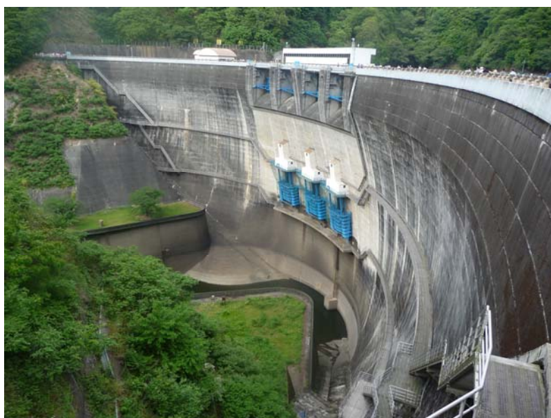
Klenbová priehrada Amagase dolnej nádrže PVE Kisenyama
