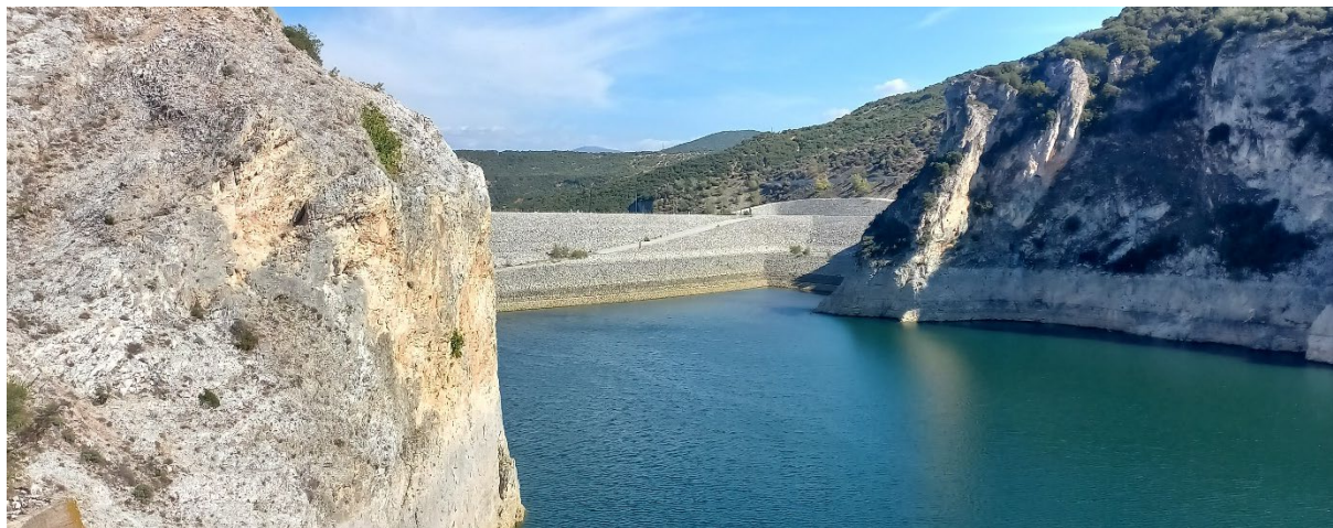
Priehrada Ilarion (výška 130 m, objem nádrže 377 mil. m 3 , VVE, zavlažovanie, zásobovanie vodou)
